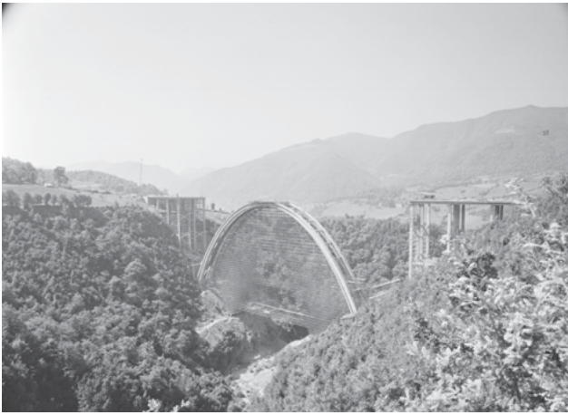
Archivio Publifoto Intesa Sanpaolo, Tino Petrelli, Lavori per la costruzione del viadotto Biscione, sul tratto autostradale Bologna-Firenze , 28 luglio 1959
